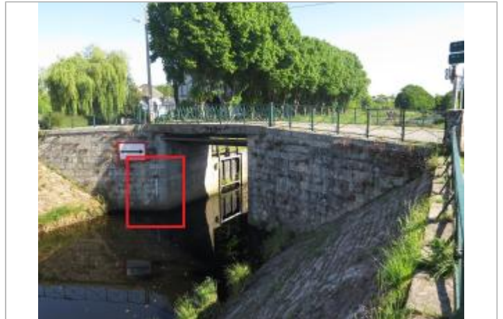
Aval de l'écluse des Recollets à Pontivy
