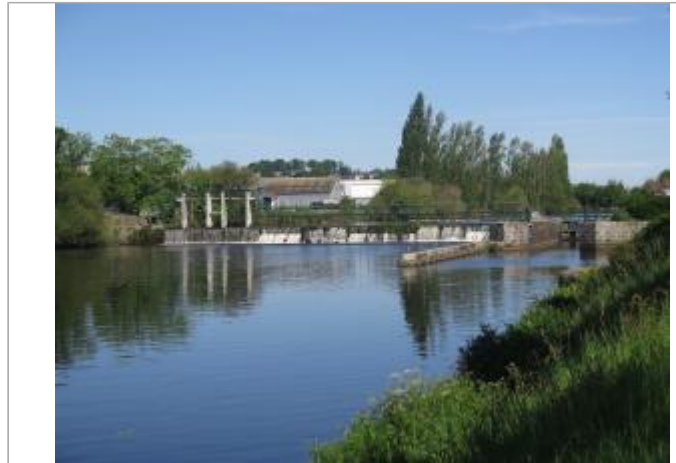
Aval de l'écluse de Lestitut à Pontivy
