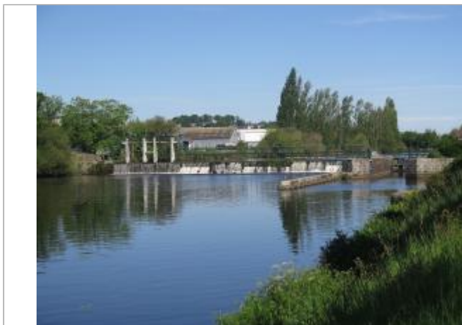
Aval de l'écluse de Lestitut à Pontivy
