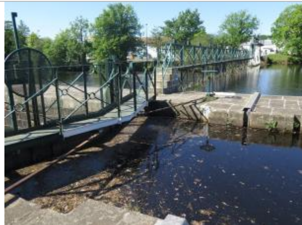
Amont de l'écluse de Lestitut à Pontivy
