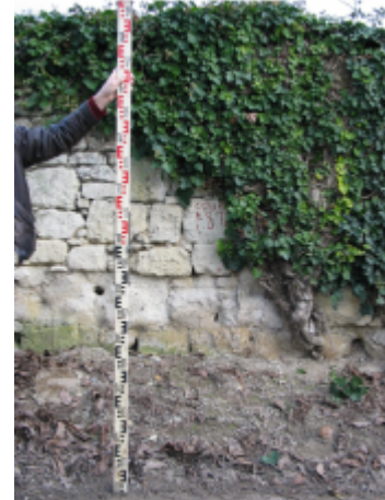
Site chemin des Zionnes 1872 (Limite sol)
