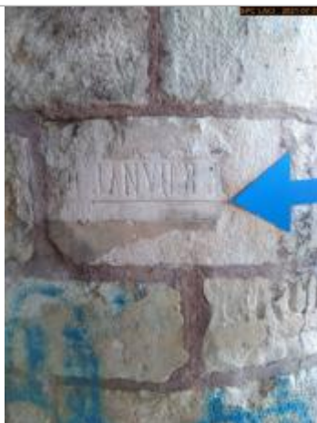
Vue du repère rapprochée en 2021
