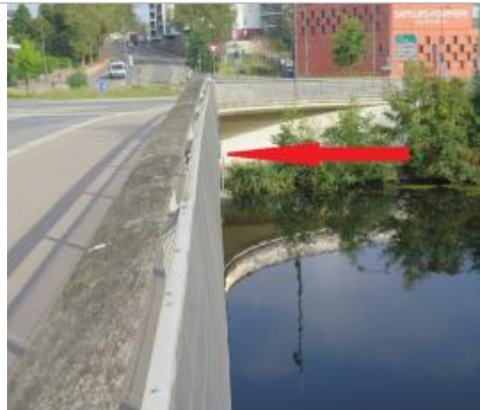
Vue du dessus du pont vaclav Havel
