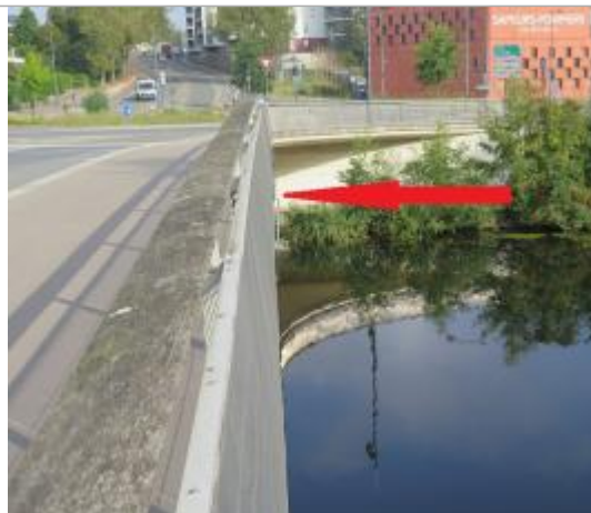
Vue du dessus du pont vaclav Havel
