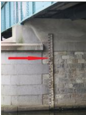
Echelle limnimétrique en amont sur la pile centrale du pont
