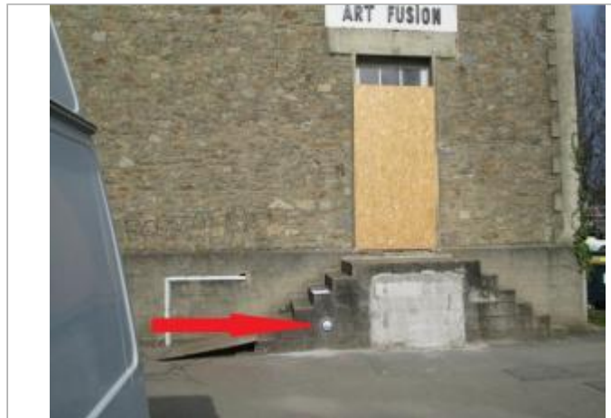
escalier entrée du bâtiment
