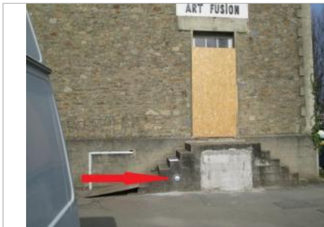
escalier entrée du bâtiment
