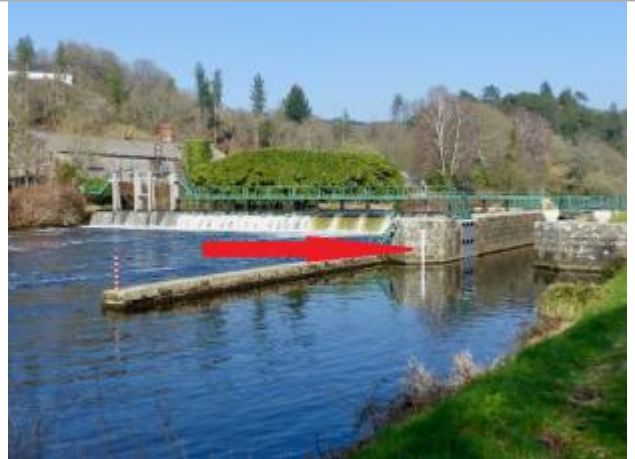
Ecluse n°18 Sainte Barbe échelle aval
