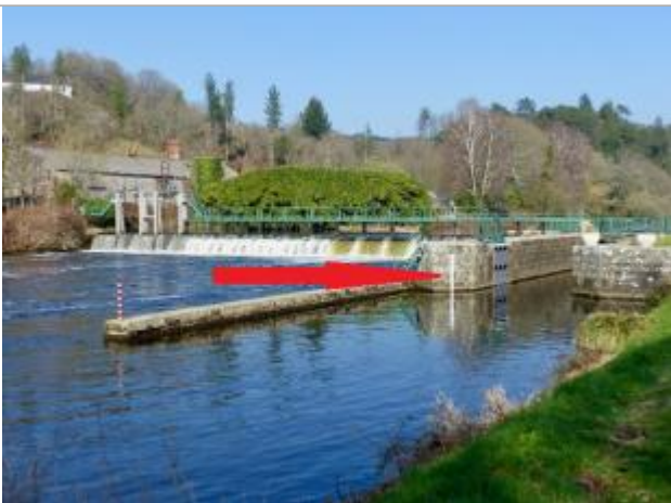
Echelle limnimétrique aval de l'écluse
