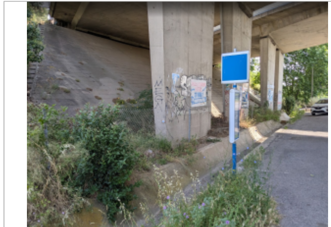
pilier pont A9
