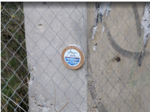
pilier pont A9
