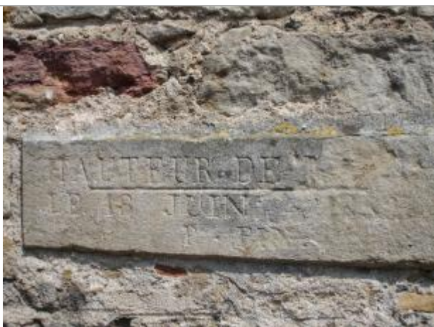
Photo du repère de crue
