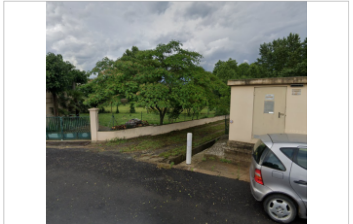
poste edf pierrenue
