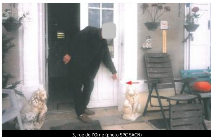
3, rue de l'Orne (photo SPC SACN)
