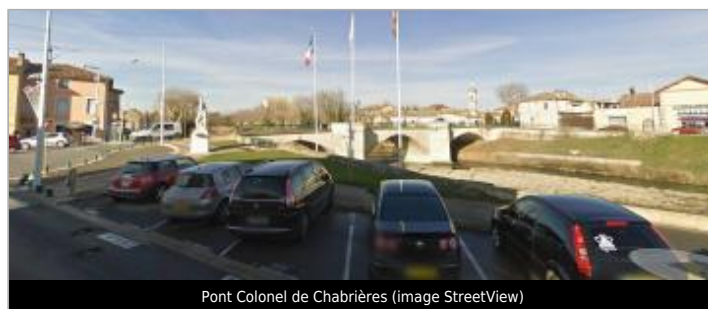
Pont Colonel de Chabrières (image StreetView)
