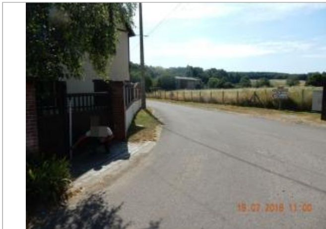
N°6 rue des Marnières (photo SPC SACN)
