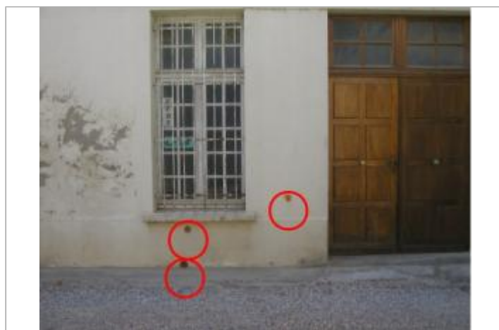
Façade bâtiment - rive droite
