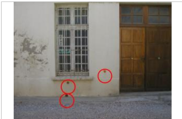
Façade bâtiment - rive droite
