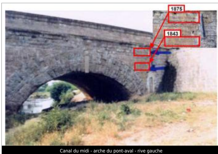
Canal du midi - arche du pont-aval - rive gauche
