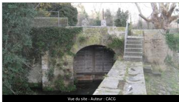
Vue du site - Auteur : CACG
