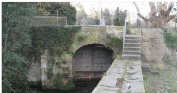
Vue du site - Auteur : CACG
