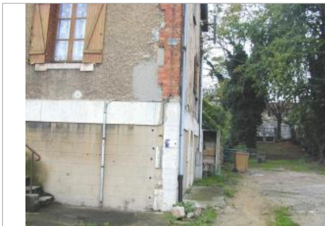
Maison éclusière au barrage de Port à l'Anglais - auteur photo : DIREN IDF
