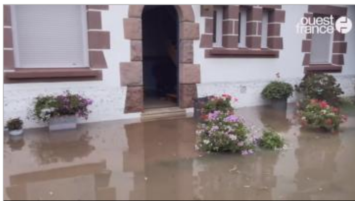
Inondation de la maison
