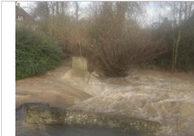
Ouvrage de la Roquette (SMBVR)
