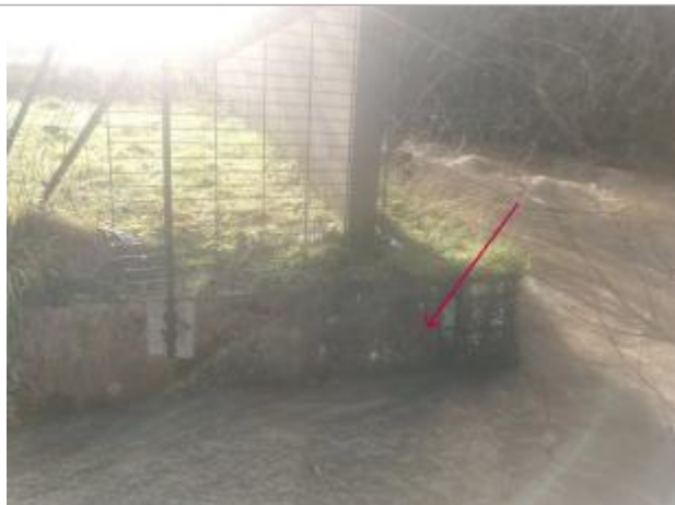
Muret de droite_ouvrage de la Roquette_Tourville (SMBVR)
