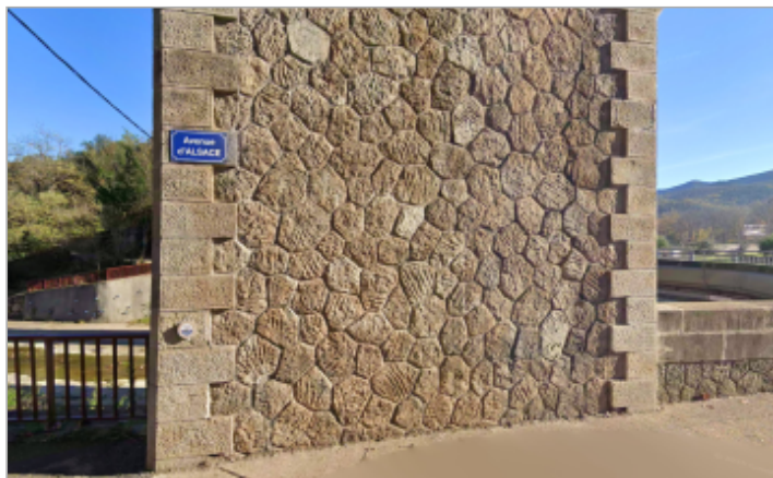
av. alsace sous pont
