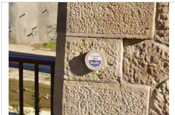
av alsace sous pont
