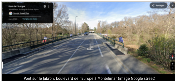
Pont sur le Jabron, boulevard de l'Europe à Montelimar (image Google street)
