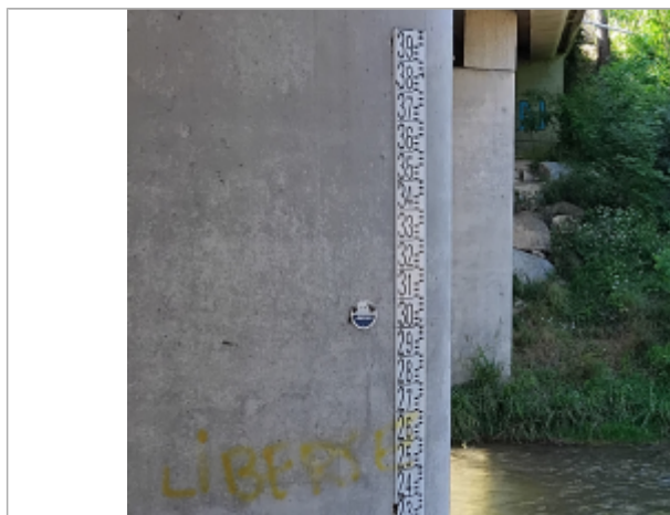
Repère apposé à l'échelle Vigicrues
