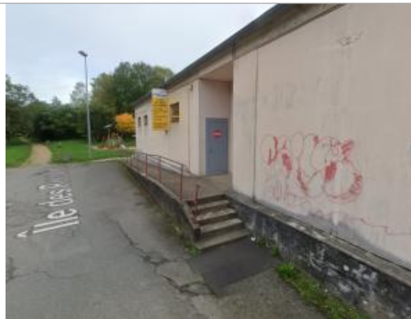
Entrée du bâtiment
