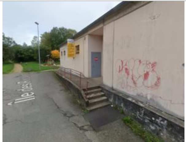
Entrée du bâtiment
