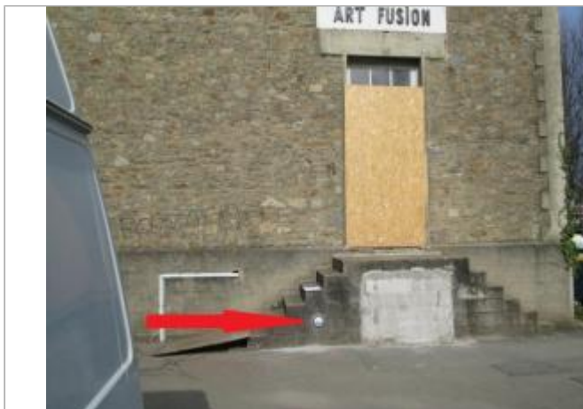
escalier entrée du bâtiment
