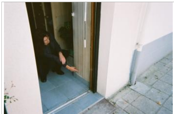
Niveau de l'inondation dans la maison
