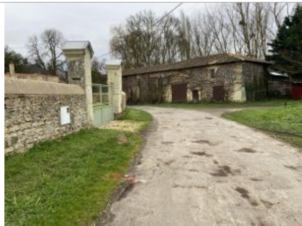
Vue du site - auteur : AGERIN
