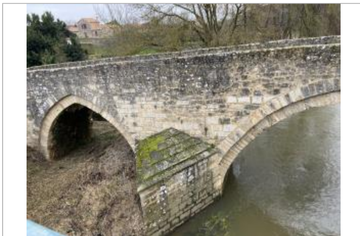
Vue du site - auteur : AGERIN
