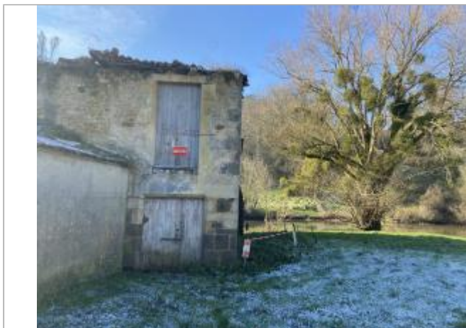
Vue du site - auteur : AGERIN
