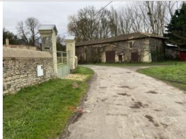
Vue du site - auteur : AGERIN
