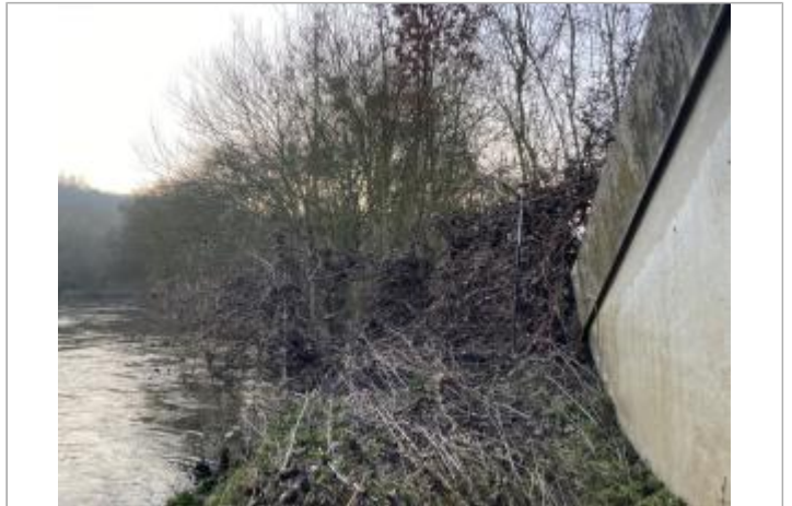
Vue du site - auteur : AGERIN
