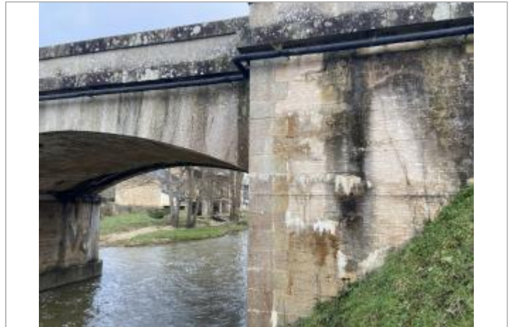
Vue du site - auteur : AGERIN
