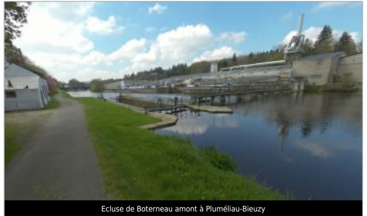
Ecluse de Boterneau amont à Pluméliau-Bieuzy
