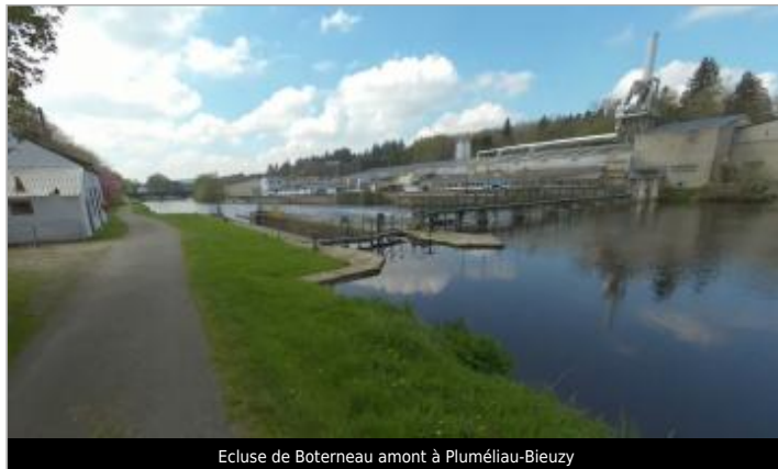
Ecluse de Boterneau amont à Pluméliau-Bieuzy
