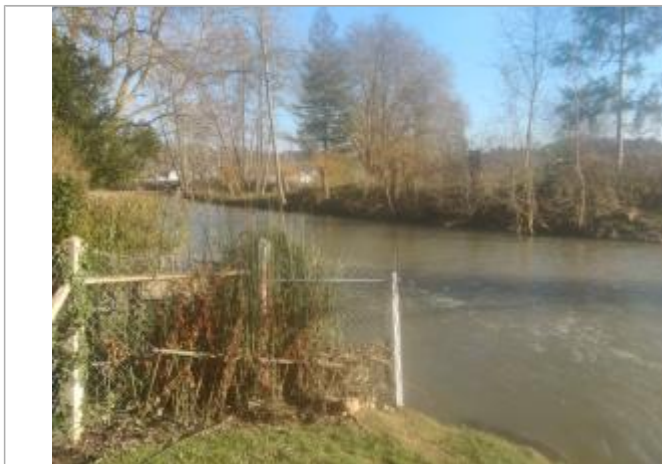
repère_laisse de crue_vue large
