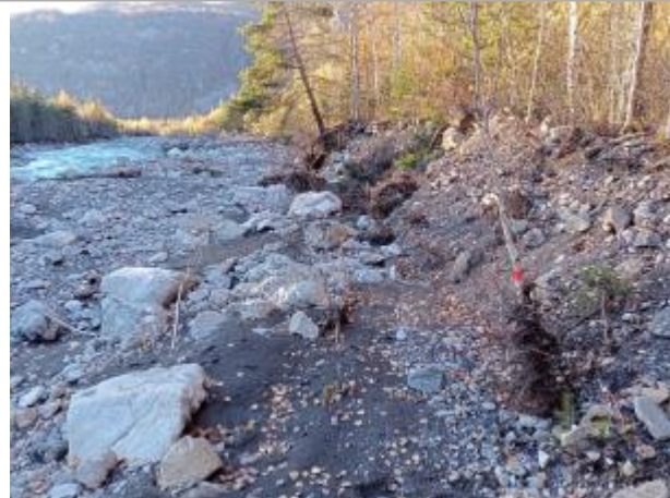
Vue générale du site. Photo © AGERIN 2023
