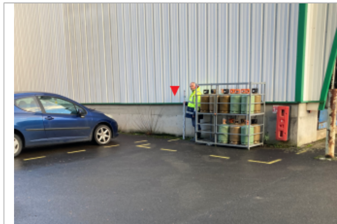
Façade de l'entrepôt
