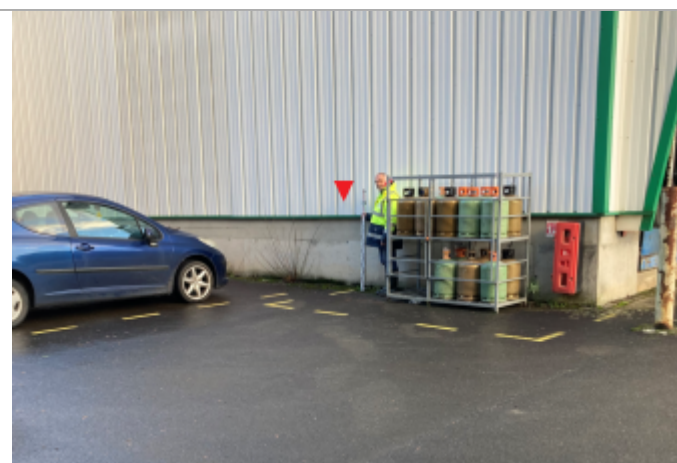
Vue d'ensemble de la façade de l'entrepôt
