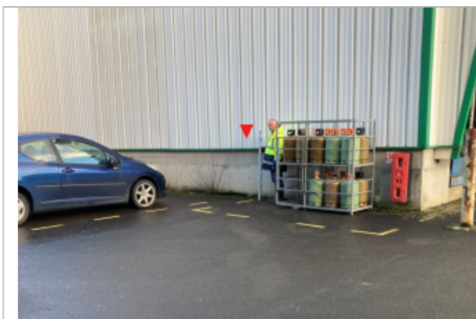
Vue d'ensemble de la façade de l'entrepôt
