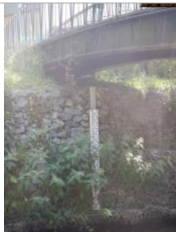
Vue rapprochée de l'échelle limnimétrique en 2023
