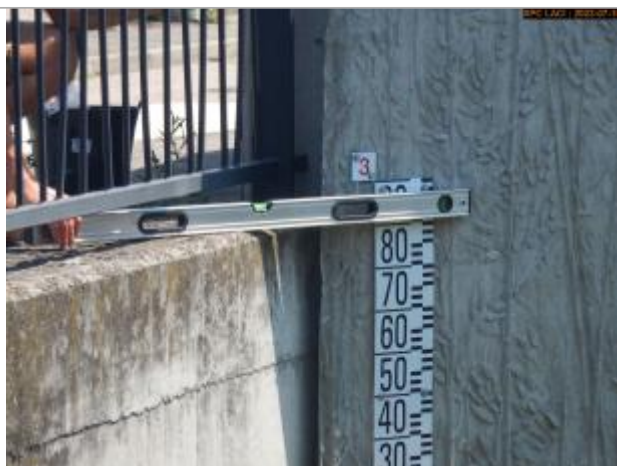
Vue de l'échelle limnimétrique
