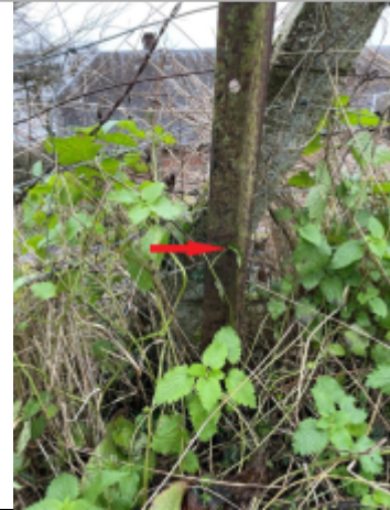
Détail sur poteau de clôture, vue proche.
