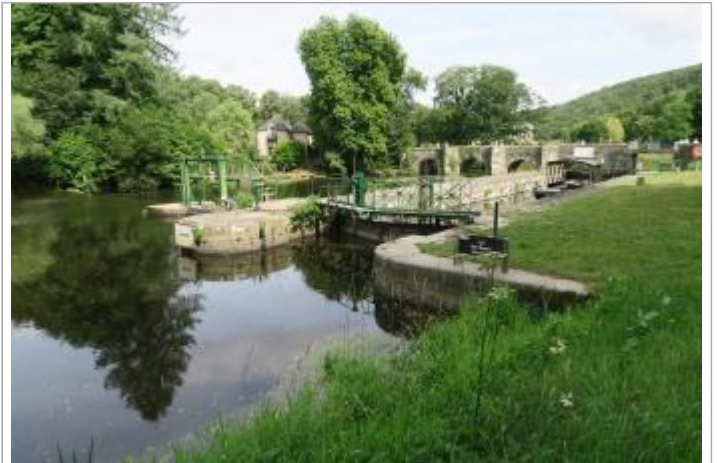
Ecluse de Bon-Repos échelle amont
