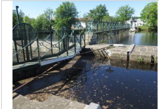
Amont de l'écluse de Lestitut à Pontivy
