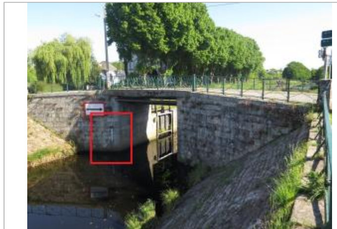
Aval de l'écluse des Recollets à Pontivy
