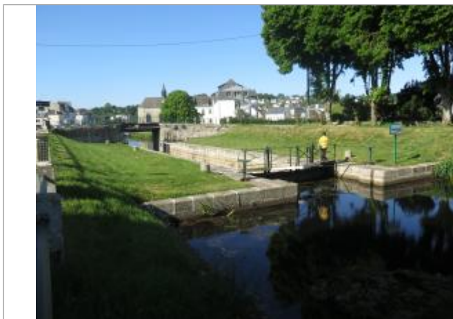
Amont de l'écluse des Recollets à Pontivy
